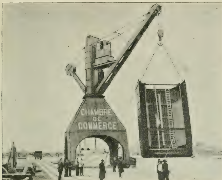
GRUE DE 50 TONNES.
